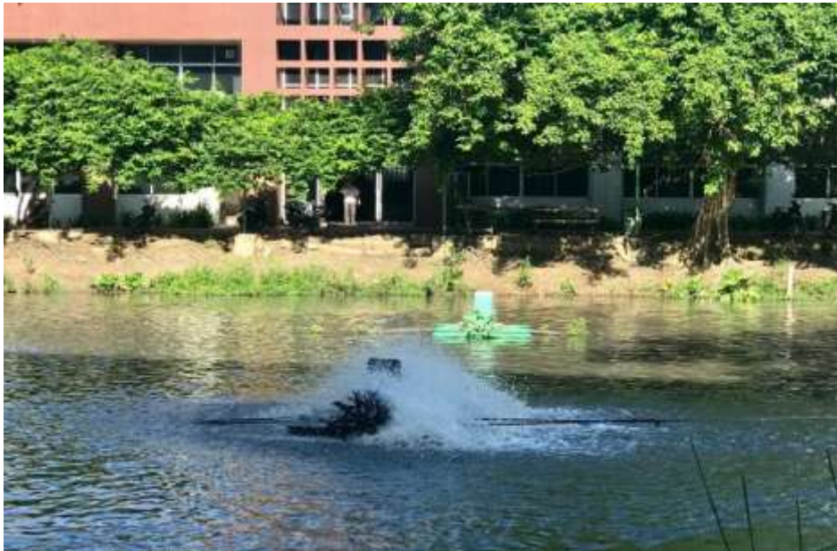
รูปที่ 12 ระบบบำบัดน้ำเสียแบบป้อเติมอากาศ (Aerated Lagoon หรือ AL)
