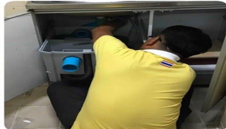
รูปที่ 14 การติดตั้งถังดักไขมัน
