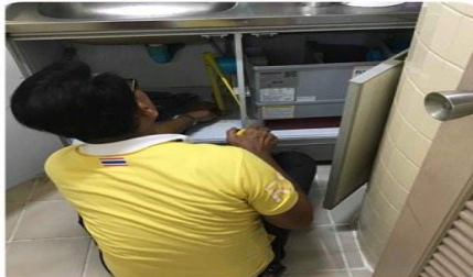
รูปที่ 14 การติดตั้งถังดักไขมัน
